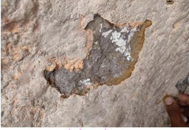
चित्र ५- भिं तीवरील मातीचा गिलावा
